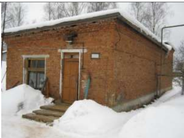
Рисунок 6.4.3.1 – Здание старой станции обезжелезивания в п.г.т. Сусанино
