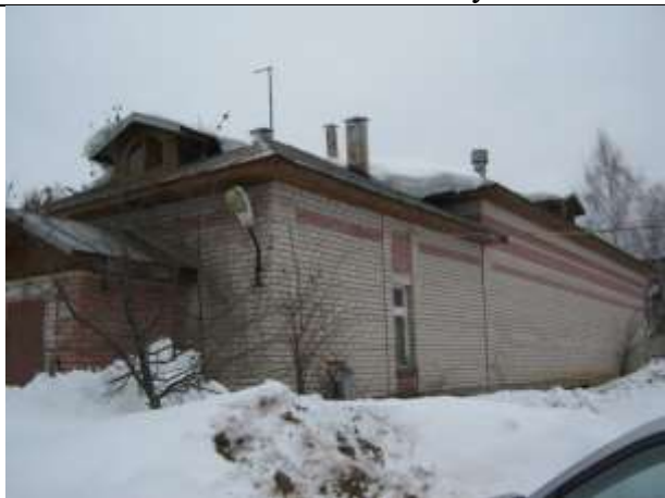
Рисунок 6.4.3.3 – Здание новой станции обезжелезивания в п.г.т. Сусанино
